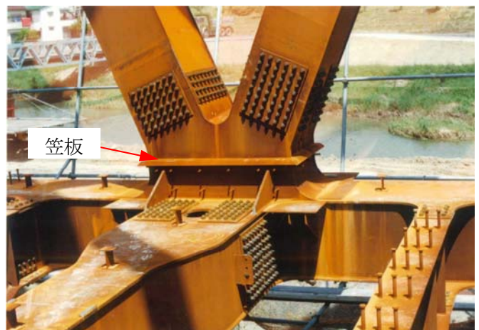
写真-5 武庫川橋梁の例
