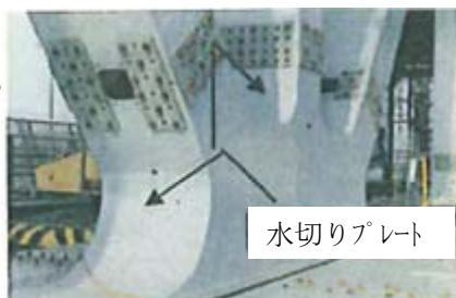
写真-2 夢の島架道橋の例
