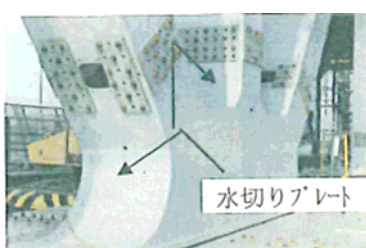
写真-2 夢の島架道橋の例
