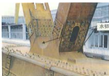
写真-1 夢の島橋梁の例
