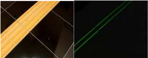
写真2高輝度蓄光ライン誘導ブロック
