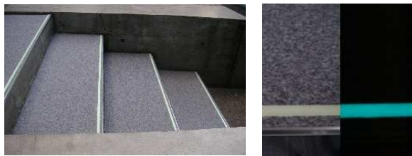
写真3 高輝度蓄光段鼻材の施工事例 写真4 明視時・暗視時の見え方
