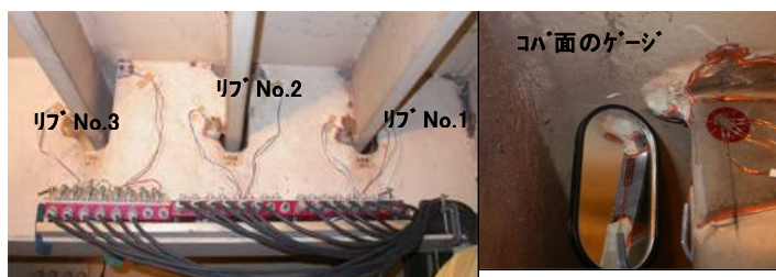
図-2 ゲージ設置状況
