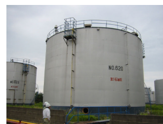
写真1. 1600KL インナーフロートタンク
