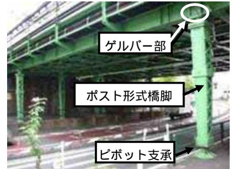
図-1 ポスト形式の橋脚を有する架道橋(解析に使用したモデル)
