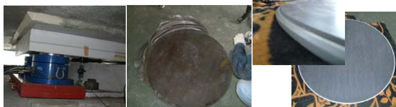
写真3.ジャッキアップ状況 写真4.撤去したPTFE 写真5.新構造すべり板
