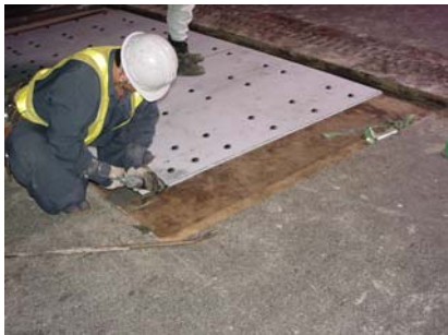
写真－１ 鋼箱桁橋の鋼床版疲労亀裂補修
