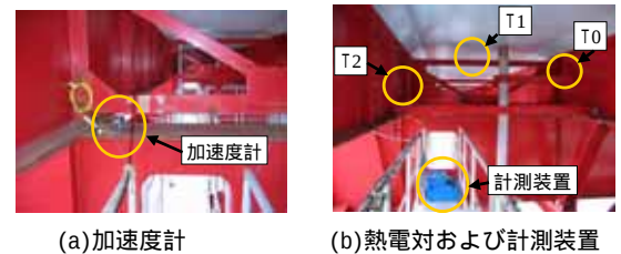
図-5 計測機器設置状況
