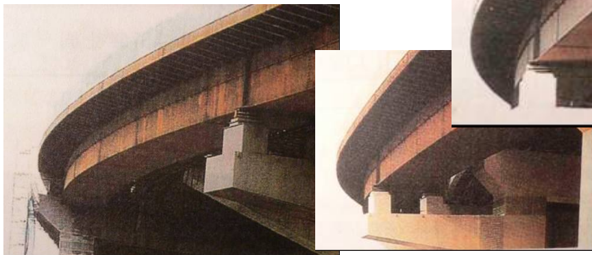
図-3 さびの組成から見た安定状態
