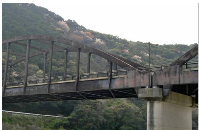
図-4 さび外観実例その 1 (一般的な例)
