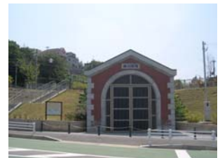
図-4 湊川隧道の入口
