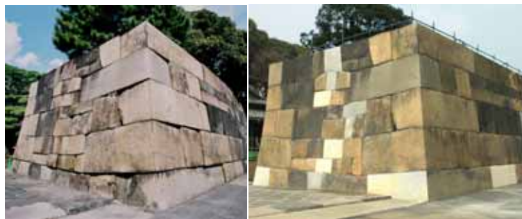
写真1 修復前・後の皇居本丸中之門石垣
