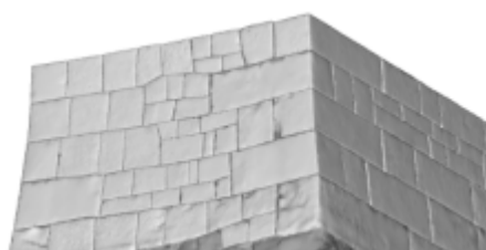
図2 案石垣隅角の稜線
