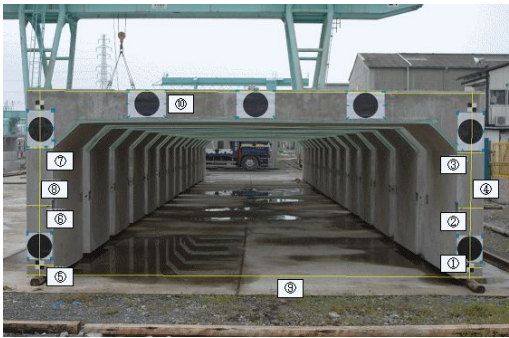
写真-2 計測箇所
