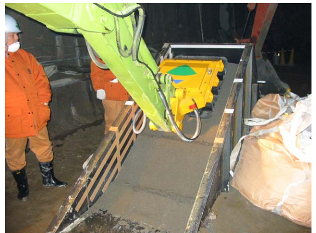
写真-1 斜め締固め実験状況
