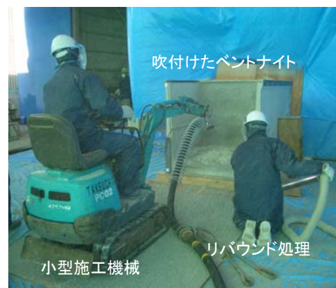
図-5 水平向きの吹付け施工
