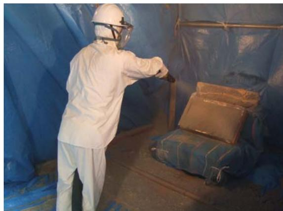
写真-2 吹付け施工試験実施状況
