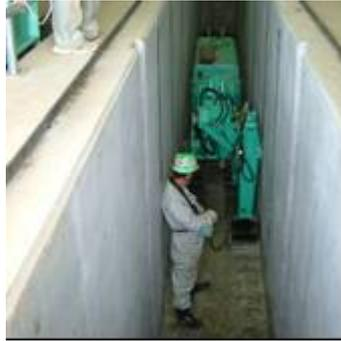
写真-2 油圧式打撃ハンマ
