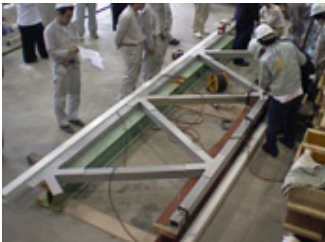
図-4 実大模型組立状況
