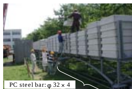
図3 死荷重載荷試験
