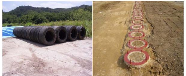
写真 - 3 原形利用した地中振動遮断壁
