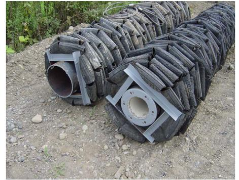
写真-1 地中振動遮断壁の形状
