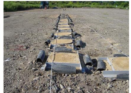
写真-2 地中振動遮断壁の埋設状況
