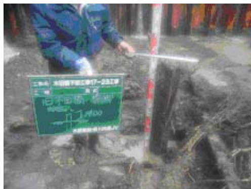
写真-1 木杭の掘出し状況
