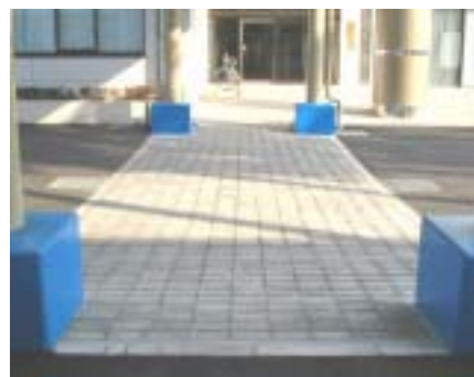
写真2 インターロッキングの敷設状況
