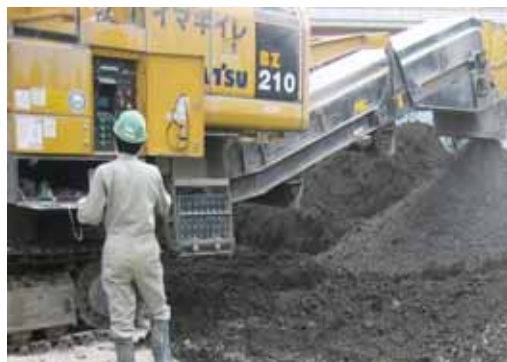
写真-1 不溶化処理工事の状況
