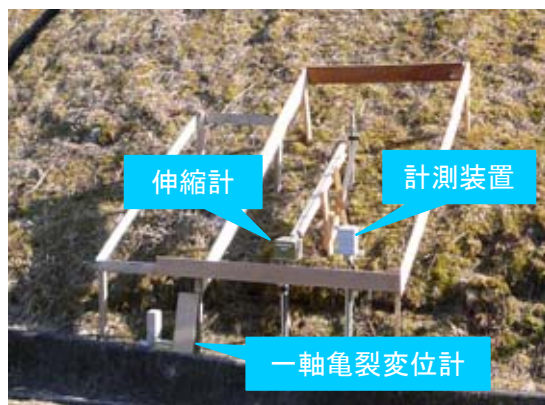
写真-2 計測装置の設置状況
