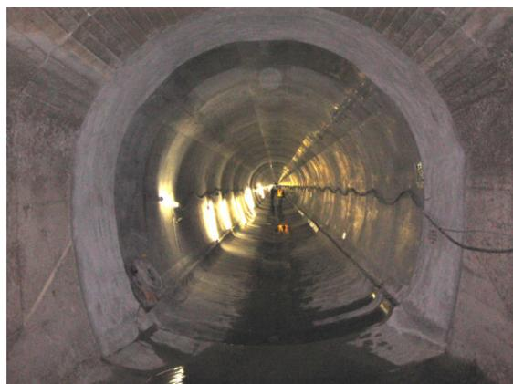
写真-3 上流側擦り付け状況
