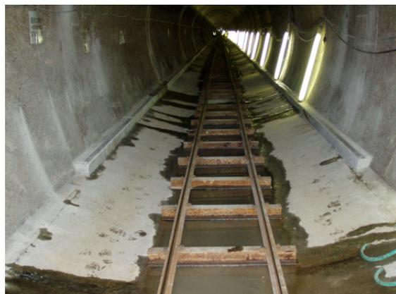
写真-1 軌道設置・脚部基礎工
