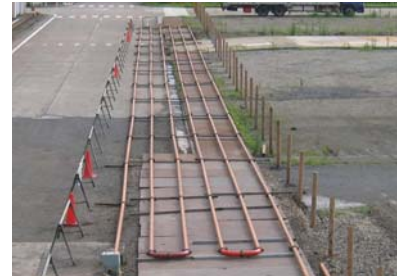
写真－2 圧送配管状況
