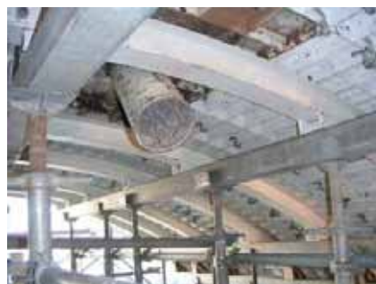
写真4 支保工・鋼製型枠・コンクリート投入口
