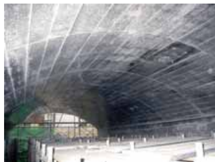
写真6 補強後状況(上床版)
