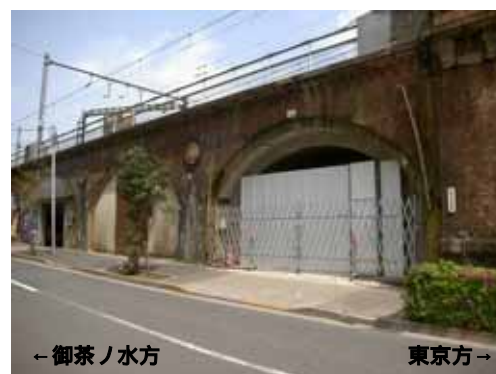
写真1 紅梅河岸高架橋
