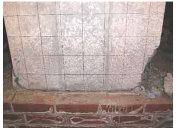
図4 載荷試験時の躯体基部の様子
