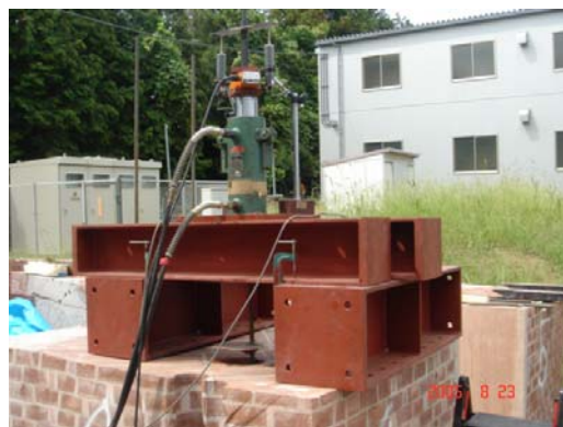
写真-1 アンカー引抜き試験状況
