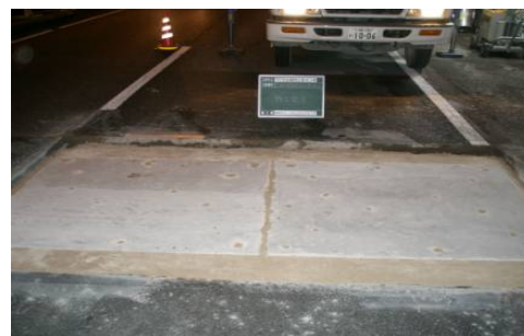
写真－2 伸縮装置部（施工後）
