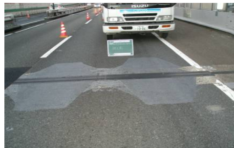
写真－1 伸縮装置部（施工前）
