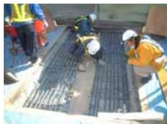
写真 - 2 はつり撤去状況 写真 - 3 鉄筋復旧状況
