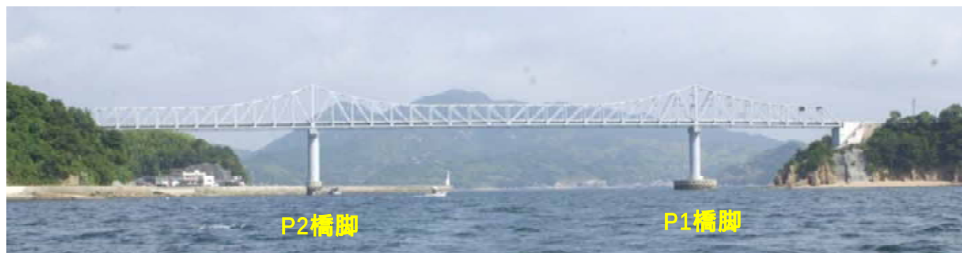
写真 - 1 橋梁全景
