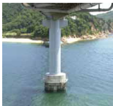
(a) P2 橋脚
