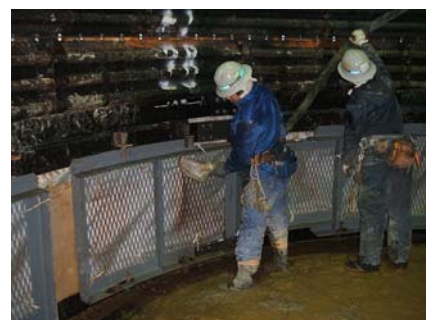
写真-1 モルタル充填状況
