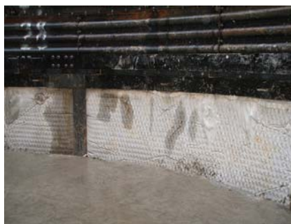
写真-2 施工出来型
