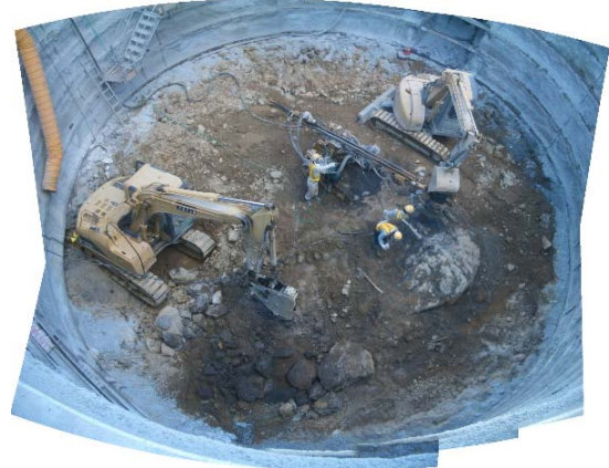
写真-4 転石破碎状況
