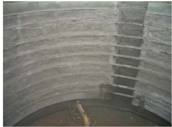
写真-3 吹付け状況
