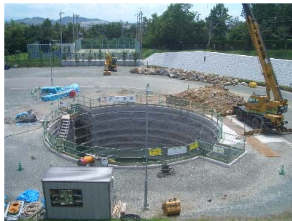
写真-1 掘削状況全景
