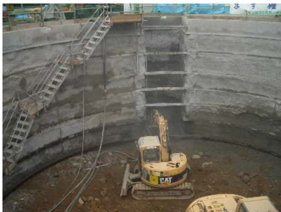
写真-2 吹付け状況全景
