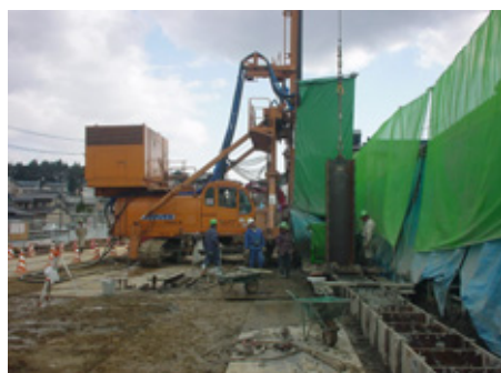
写真 - 1 NS-BOX 建込み
