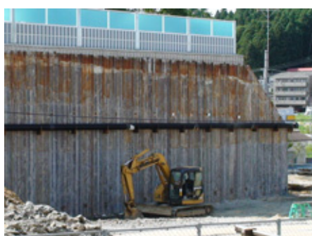
写真 - 2 前面掘削
