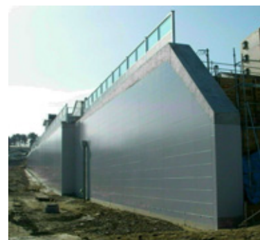
写真 - 3 表面仕上げ後の壁面
