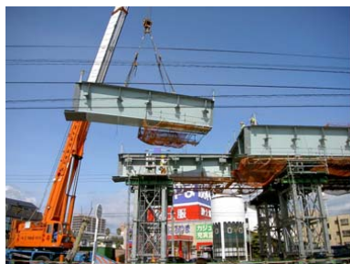
写真-5 上部工地組立
