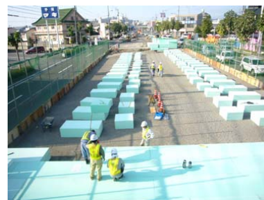
写真-7 EPS盛土の施工
