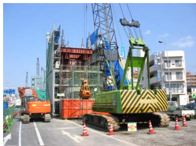
写真-2 ケーソン圧入掘削
