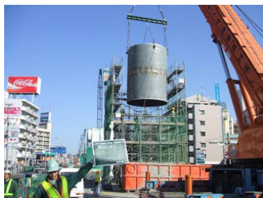
写真-3 ソケット鋼管設置
