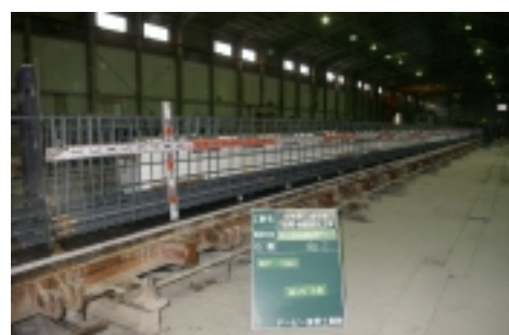
写真-1 P C 桁の製造状況
