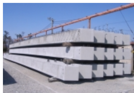
写真-2 完成したP C 桁製品
