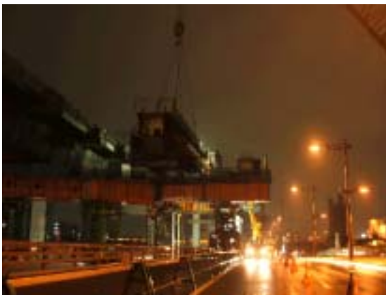
写真1 ベント工法による架設状況
