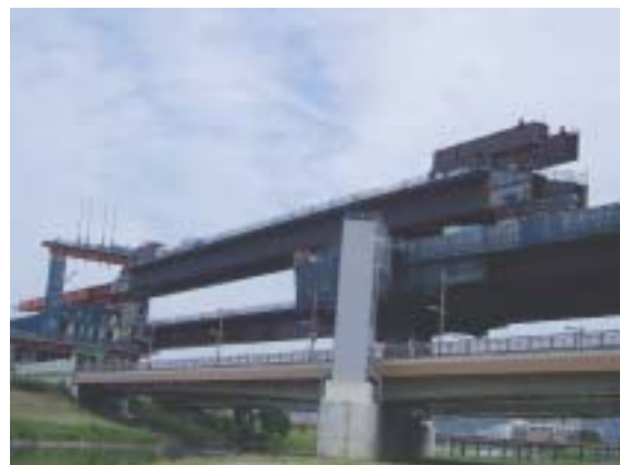
写真2 送り出し工法による架設状況
