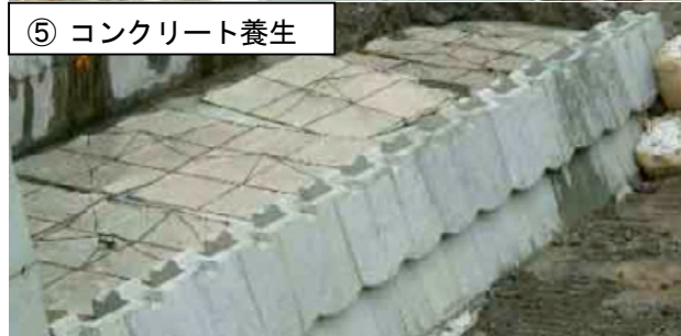
写真-2 無人化施工対応自立式型枠ブロックの施工方法
