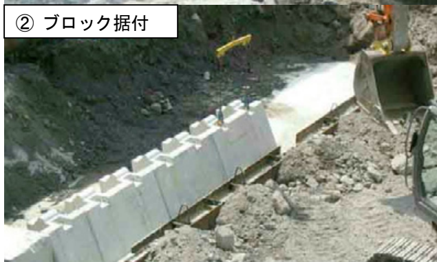
写真-2 無人化施工対応自立式型枠ブロックの施工方法
