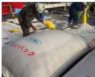
写真-4 充填口換装状況
