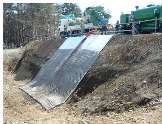
写真-2 注入状況
