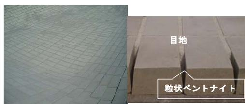
写真-1 敷設全景・BB 継目部状況
