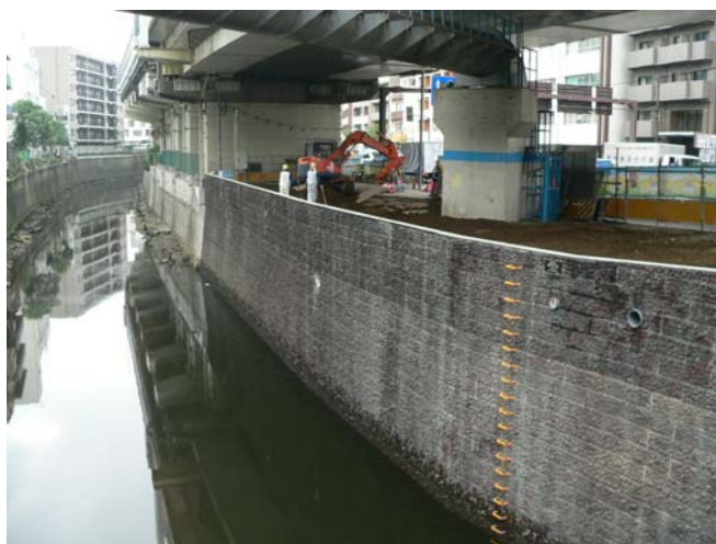
写真-6. 護岸完成
