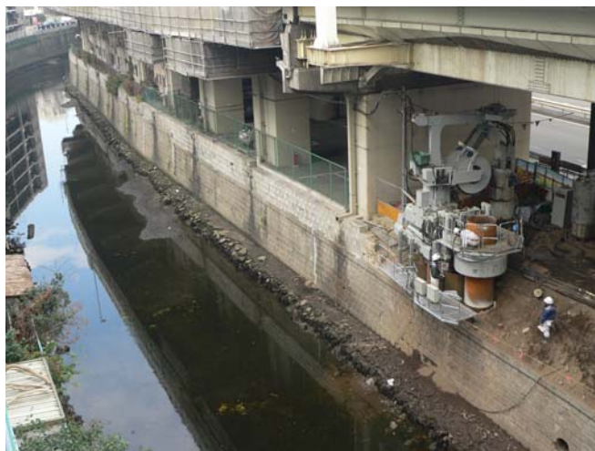
写真-4. ジャイロクリアパイラー施工状況
