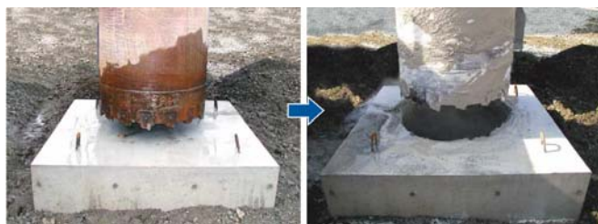
写真-1.鉄筋コンクリート切削状況
