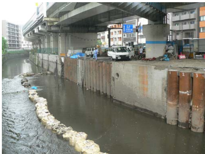
写真-5. 杭設置後
