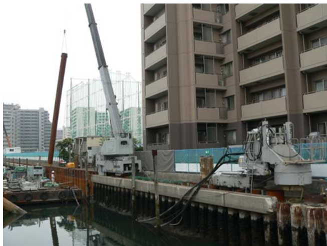
写真-3. ノンステーピング工法施工状況
