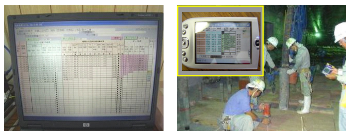
写真-1 作業地点の施工状況 (左=PC画面, 右=ホース筒先)
