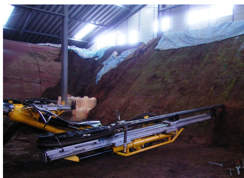
写真－1 試験施工状況
