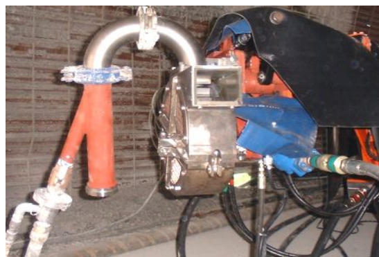
写真2 インペラヘッドと スラリー化ノズル コンクリート投入管
