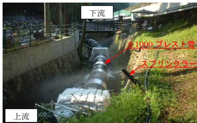
写真-1 河川切廻し・散水状況
