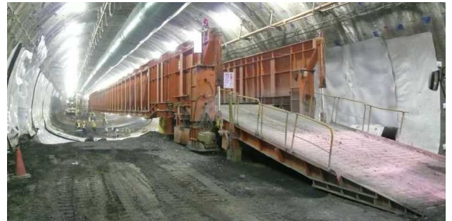
写真-2 インバート長大栈橋
