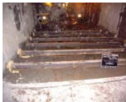
写真2 インバートストラット設置状況
