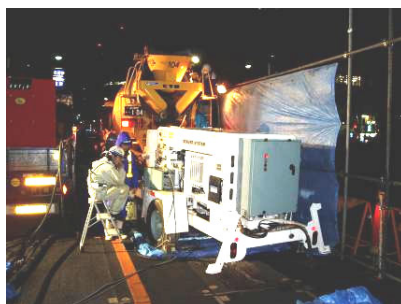
写真-3 施工状況（プラント）
