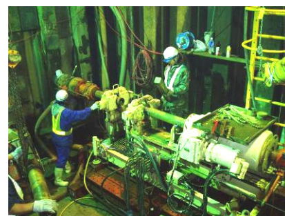
写真-2 施工状況（造成）
