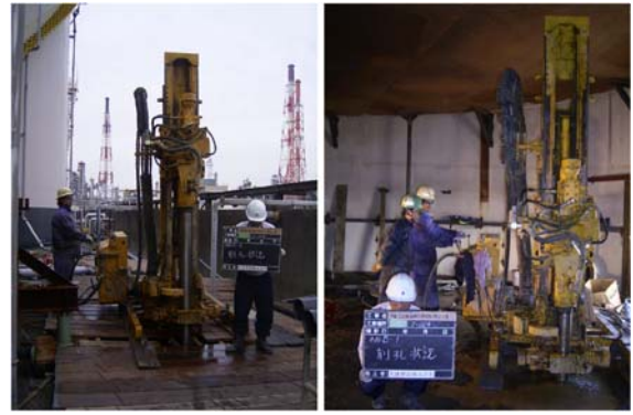
写真-1 削孔状況 (左-タンク周囲 右-タンク内)
